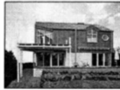
Aus- und Umbauten Baureparaturen
