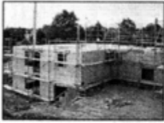
Hoch- und Tiefbau Stahlbetonbau
